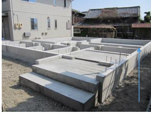
構造の荷重を面で受け分散するベタ基礎
