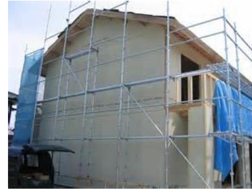
外部の柱に9mmの面材を直接貼ることで基準以上の耐力性を確保します。また、壁厚になることで、断熱性、気密性、防音性も効果があります。
